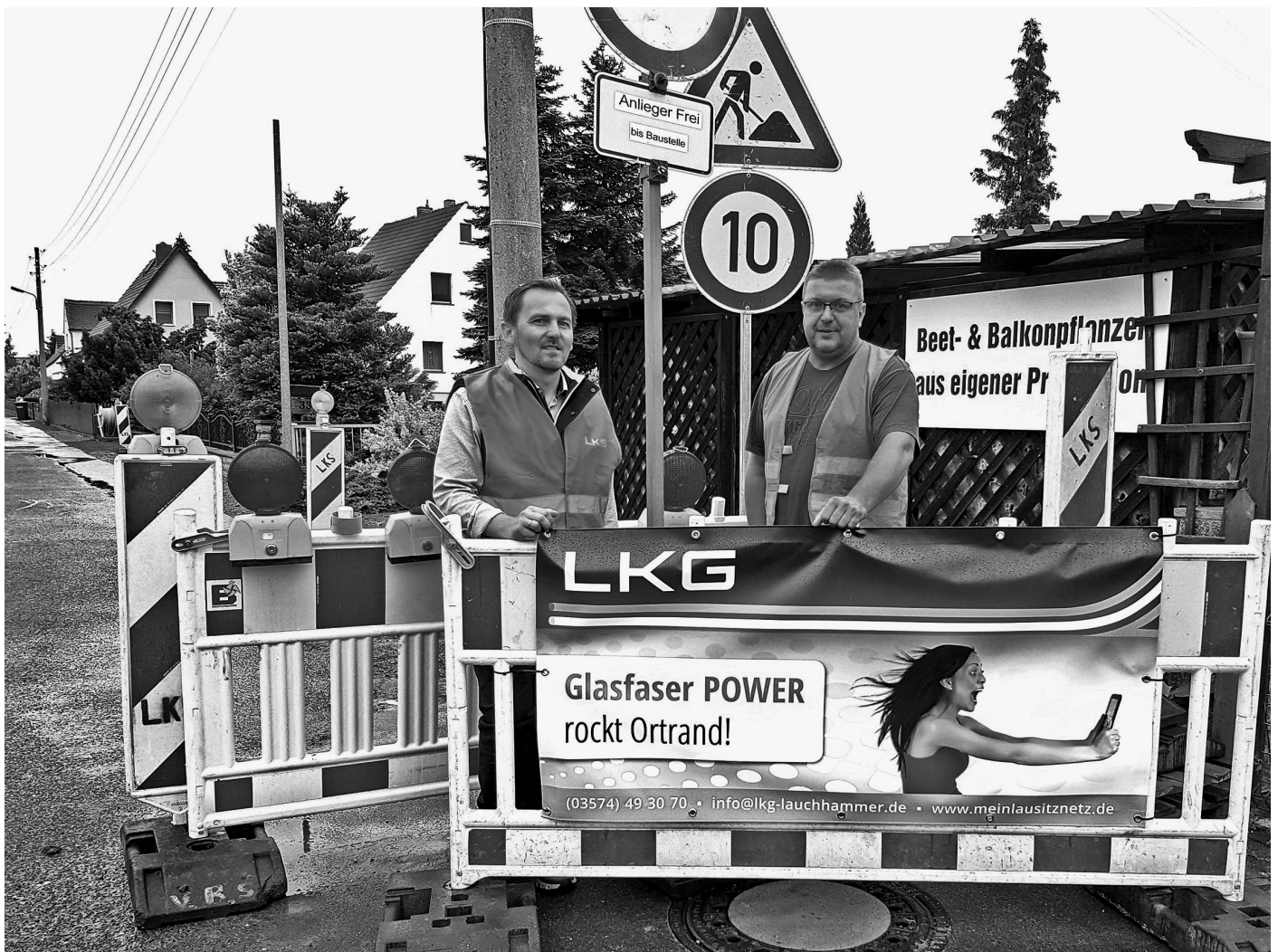
Herr Niebuhr (LKG Lausitzer Kabelbetriebsgesellschaft mbH) und Herr Schielinski (Elektro Mittag GmbH) am Absperrungszaun der Baustelle Brautgasse erwarten Ihre Hausanschlussmeldung für die Glasfaserkabelverlegung.
