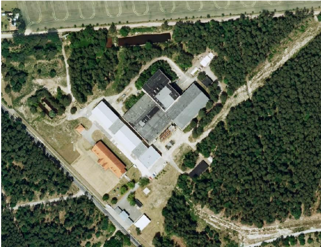
Abbildung 1: Satellitenbild mit Wasserwerkgebäude vor dem Abriss der alten Gebäude, o.M.
