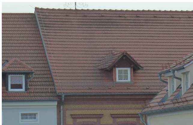
Abb. 1a, 1b: Angaben für maximale Dachüberstände an Traufen und am Ortgang (links. Typische Dachform ist das symmetrisch aufgebaute Satteldach mit Tonziegeldeckung in rötlich-braunem Farbton (rechts).
