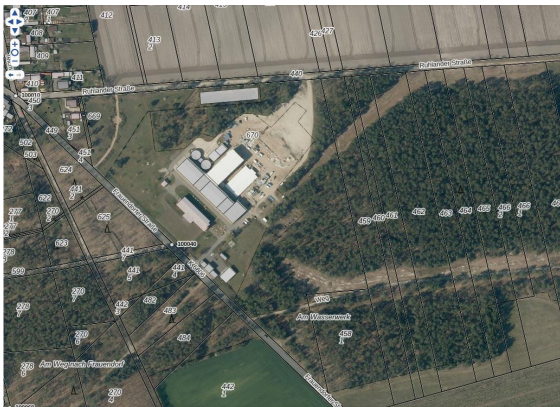
Abbildung 2: Luftbild vom Vorhabengebiet o. M.
