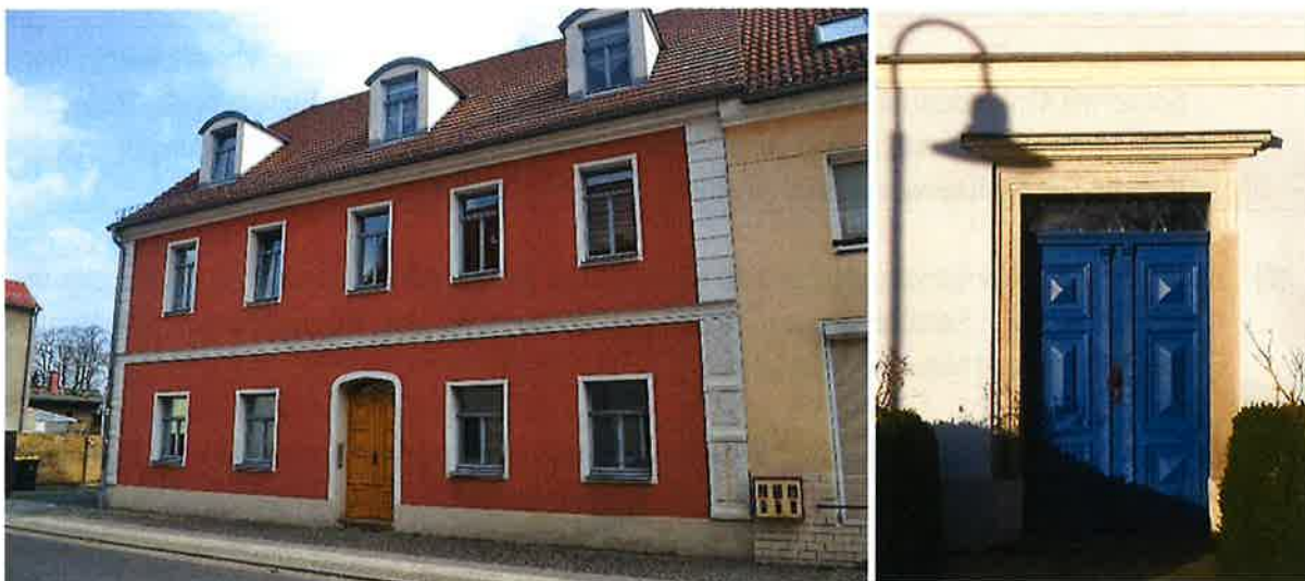
Abb. 4a, 4b: Fensterfaschen, Lisenen sowie Eckbetonungen akzentuieren die sonst als Putzfassade ausgebildeten Wandflächen (links), markante Türgestaltung und Türrahmung durch Natursteingewände (rechts).
