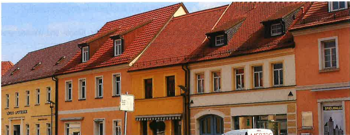
Abb. 3: Der Einzelhauscharakter wird durch den Wechsel unterschiedlicher Gestaltungselemente erreicht. Trotzdem bildet die Häuserzeile ein harmonisches Ganzes durch die Wiederkehr gleicher Fassaden- und Öffnungsproportionen wie die gleichmäßige Reihung stehender Fensterformate.
